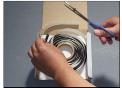
ガスケットを斜め 45° にカット
